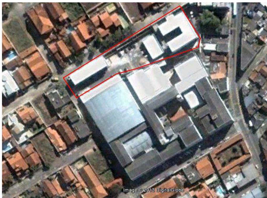
Figura 4: Vista aérea das instalações do Campus Avançado Três Corações Fonte: Google (2013)
